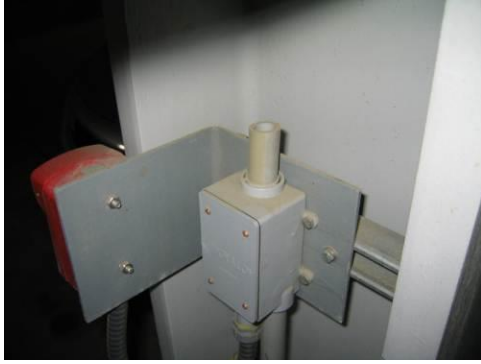
2-20 Open conduit -fire alarm box
